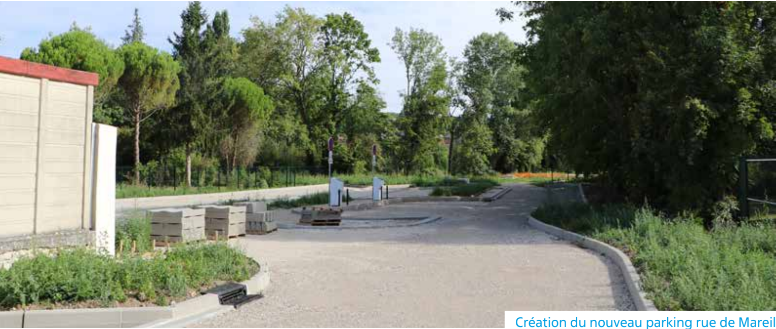
Création du nouveau parking rue de Mareil
