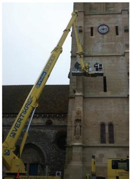
Au préalable à cette intervention, la façade a été nettoyée et traitée avec un anticryptogamique, ceci a été réalisé à l'aide d'une grue nacelle afin d'éliminer les traces verdâtres les bandeaux, les plans inclinés et les parties saillantes.
