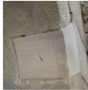
Il est mis en oeuvre puis scellé en mortier de chaux
