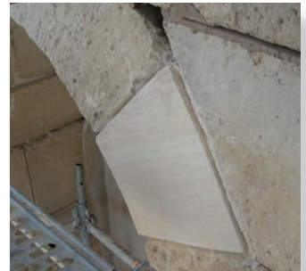
Il est mis en oeuvre puis scellé en mortier de chaux
