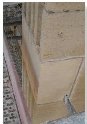
Mise en place et scellement. Les cannelures seront retaillées à l'outil lors des finitions.
